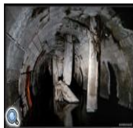
Повреждение коллектора бетонными сваями
